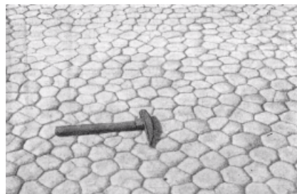
Рис. 14.19. Трещины усыхания в глинистых осадках
