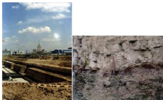
Рис. 1.4. Каменноугольные отложения Московского мегаполиса: слева – общий вид (котлован будущего Москва-Сити, 1999), справа – деталь (слои светло-серых известняков разбиты трещинами)
