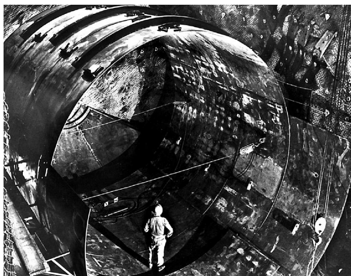
Рис. 3. Строительство детектора в шахтах Хоумстейк
